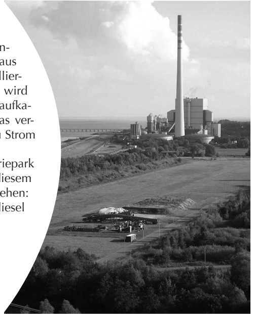
Ein Kohlekraftwerk an der Nordsee.
